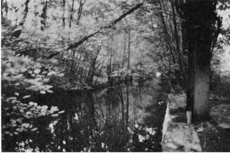
18) Großer Beileitungsgraben der Sieber vor Herzberg. Er entzieht der Sieber den größten Teil des Jahres fast ihre gesamte Wassermenge, und leitet sie als Produktions- und Kühlwasser den Herzberger Papierfabriken zu.
