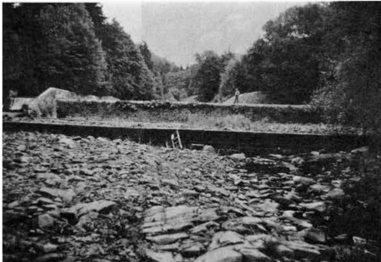
17) Sperrwerk im Sieberflußbett oberhalb Herzbergs. Es dient der Ableitung und Regulierung der Produktions- und Kühlwässer für die Papierfabrik in den Beileitungsgraben. Dieses Bauwerk und die starke Wasserableitung stellen einen schwerwiegenden Eingriff in das biologische Flußsystem Sieber dar. Es schneidet unter- von oberliegenden Lebensgemeinschaften ab und entzieht ihnen das zum Fortbestehen notwendige Wasser.
