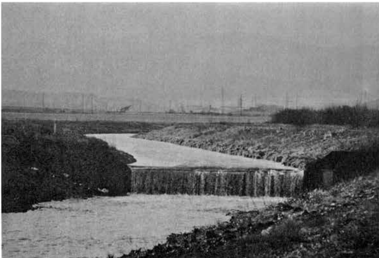
23) Die Oker, im Hintergrund das Industriegebiet der Stadt Oker. Sie ist hier auf mehrere Kilometer Länge "verbaut", in eine mit Gefällestufen ausgestattete, monotone Rinne gezwungen. Entsprechend ist die Armut der fließbegleitenden Tier- und Pflanzenbestände.
