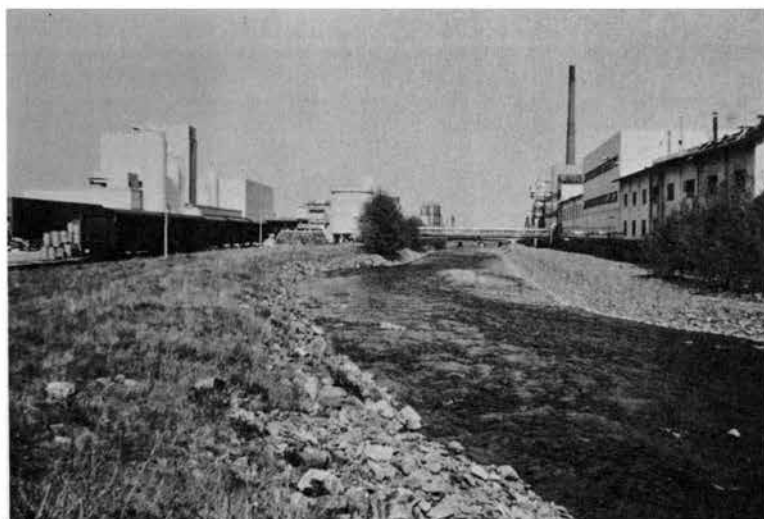
10) Die Innerste beim Durchfluß des Mineraldünger-Firmengeländes "Synthometer", kurz vor Langelsheim.
