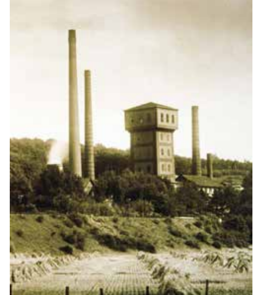
Abb. 9: Der nach dem 1. Weltkrieg errichtete neue Förderturm von Schacht II
