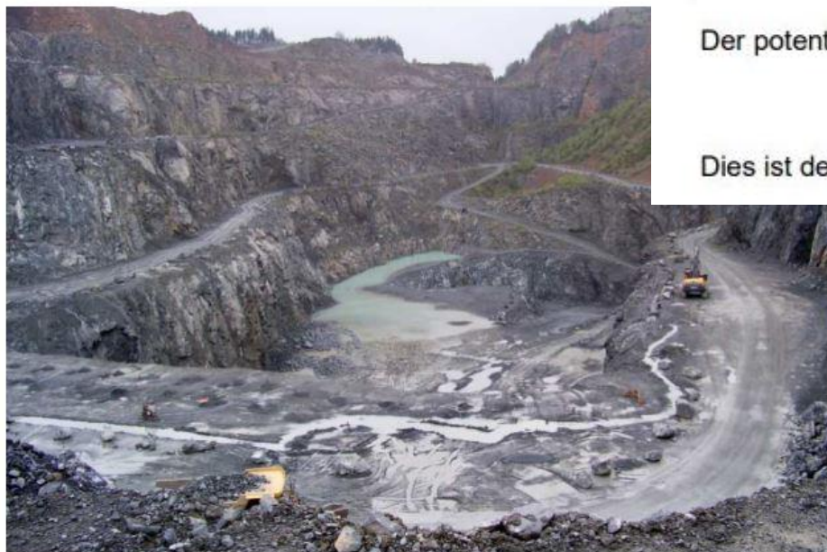
Abbildung 4: Ansammlung der dem bestehenden Tagebau hauptsächlich aus dem Übergangsbereich Locker- zu Festgestein zufließenden Wasser (Aufnahme bei Starkregen; Blickrichtung in Richtung Südwesten)
